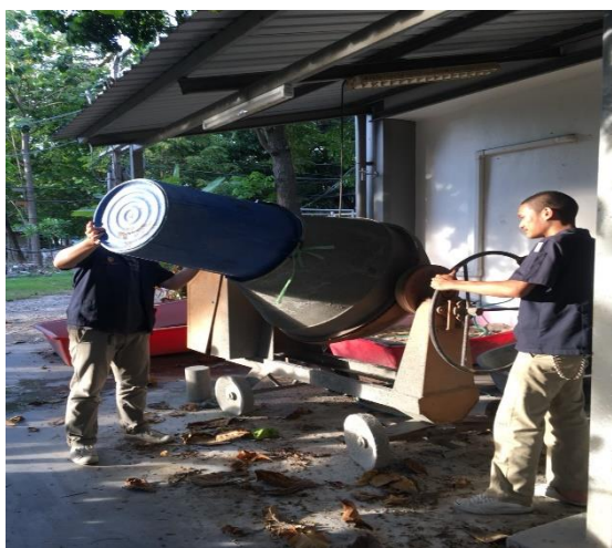
รูปที่ 3.3 ผสมคอนกรีต
