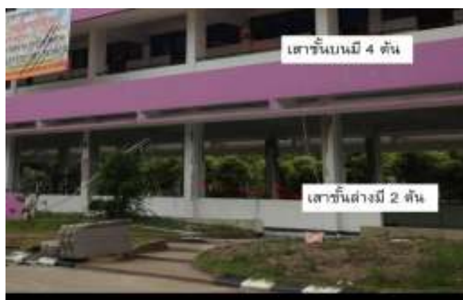
รูปที่ 2.1.4 ตามขวางอาคารมีเสาเพียง 2 ต้นในชั้น 1 ในขณะที่ชั้นบนมีเสา 4 ต้น (สำนักงานกองทุนสนับสนุนการวิจัย,2557)
