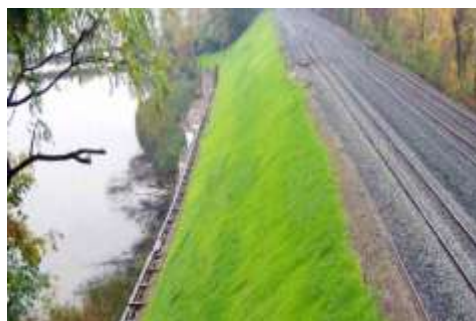
(ข) ลาดดินทางรถไฟ
