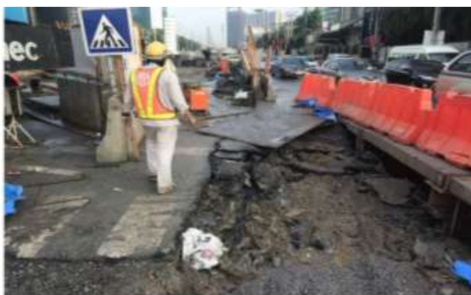
รูปที่ 2.4 ดินทรุดตัวบนถนนรัชดาฯ เข้า
