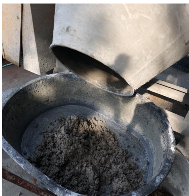
รูปที่ ค6 การผสมคอนกรีต
