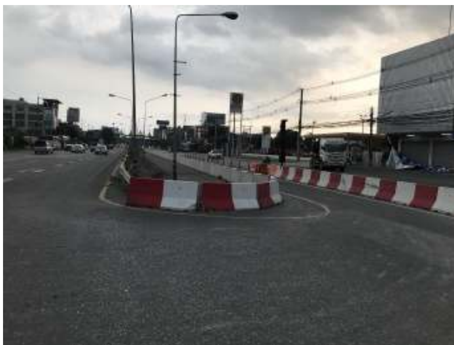
รูปที่ 6 บล็อกคอนกรีตที่ช่วยป้องกันรถจากทางตรง
