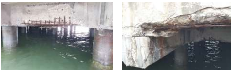
ภาพที่ 2-1 ความเสียหายของโครงสร้างคอนกรีตเสริมเหล็กอันเนื่องมาจากคลอไรด์
