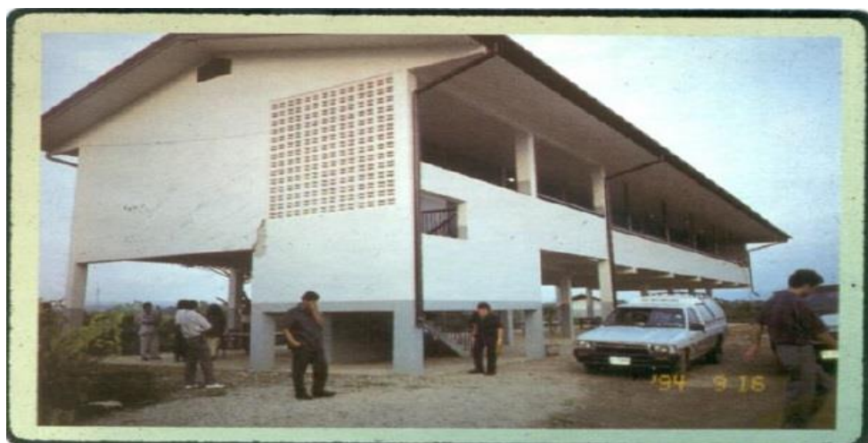
รูปที่ 2.15 อาคาร คอนกรีตเสริมเหล็ก โรงเรียนแห่งหนึ่ง มีลักษณะชั้นอ่อน และไม่ปกติเชิงบิด
