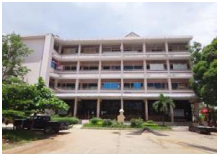
รูปที่ 2.20 โรงเรียนเทศบาล 1 อำเภอฟาน จังหวัดเชียงราย อาคารคอนกรีตเสริมเหล็ก 4 ชั้น
