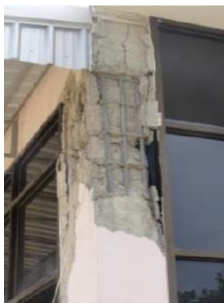
รูปที่ 2.21 โรงเรียนเทศบาล 1 อำเภอฟาน จังหวัดเชียงราย ชั้นล่างเสาโค้ง ผนังเบา
