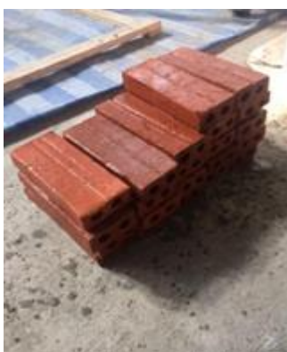
รูปที่ 3.3.1 ราดน้ำอิฐเพื่อไม่ให้อิฐดูดน้ำ
