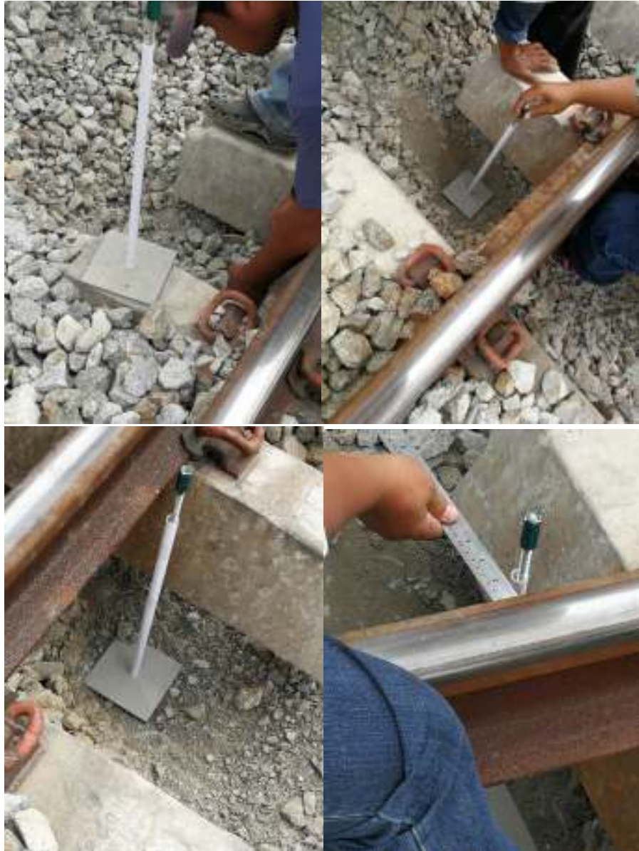
รูปที่ ข-5 การติดตั้ง Settlement plate
