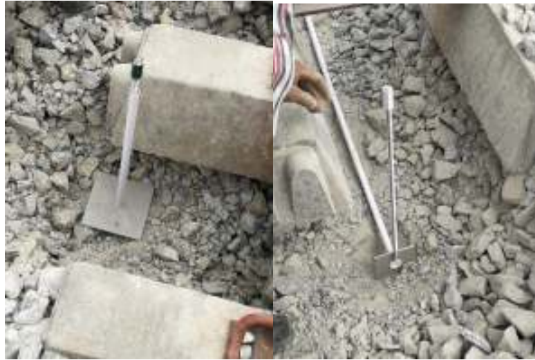
รูปที่ 3-9 Settlement Plate และ Extensometer
