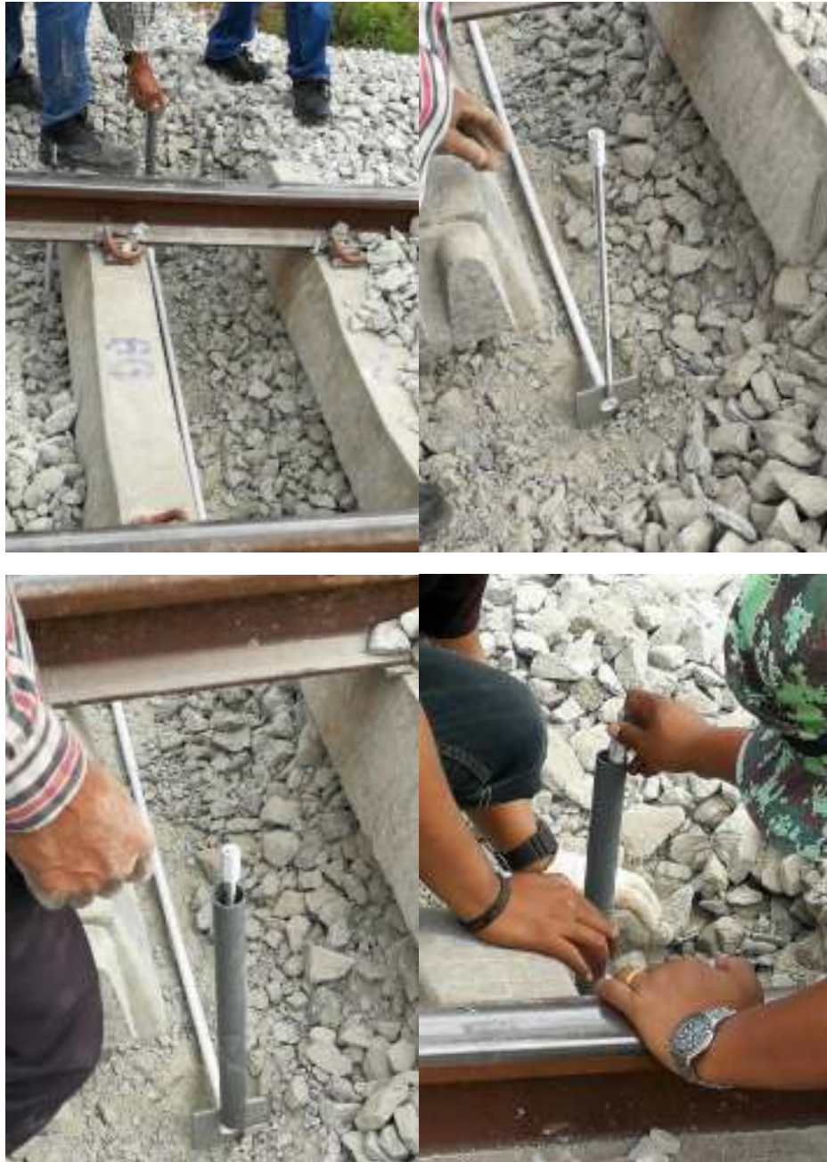
รูปที่ ข-6 การติดตั้ง Extensometer
