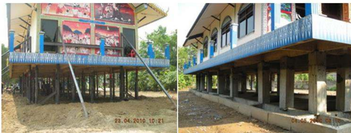
รูปที่ 2.8 ตัวอย่างการยกอาคาร
