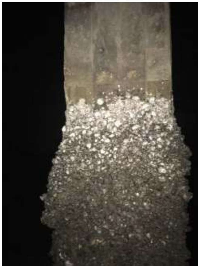
ภาพที่ 8 ตัวอย่างความเสียหายจากสัตว์น้ำทะเล
