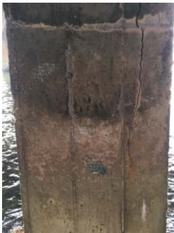
ภาพที่ 5 ตัวอย่างความเสียหายของเสา
