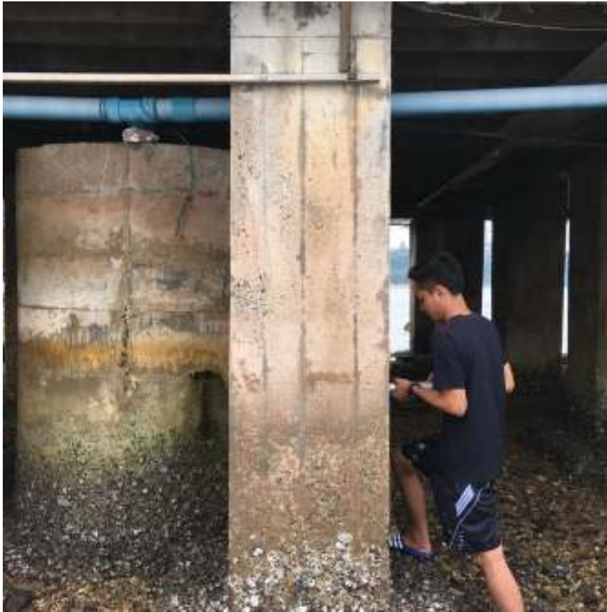
ภาพที่ 2 การทดสอบกำลังรับแรงอัดของเสาด้วย rebound hammer
