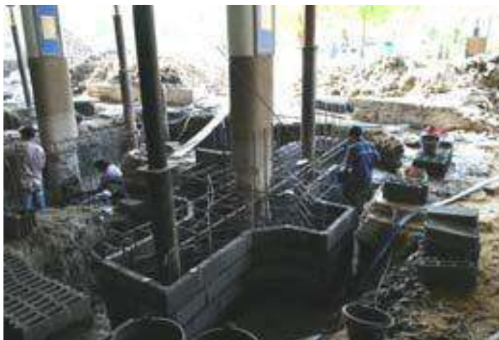
ภาพที่ 2.30 การเสริมความแข็งแรงของฐานรากอาคารด้วยเสาเข็ม Micropile แนวด้านหน้าอาคาร
