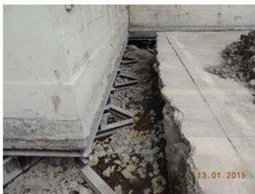
รูปที่ 2.22 ลักษณะคานเหล็กวางเสริมตลอดใต้ผนัง
