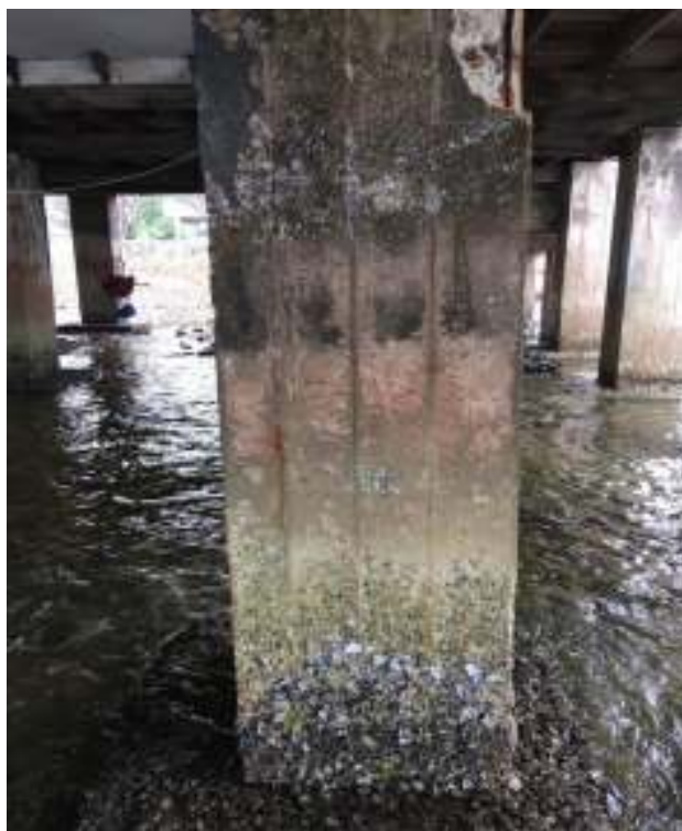
ภาพที่ 7 ตัวอย่างรอยความเสียหายจากการหลุดร่อน
