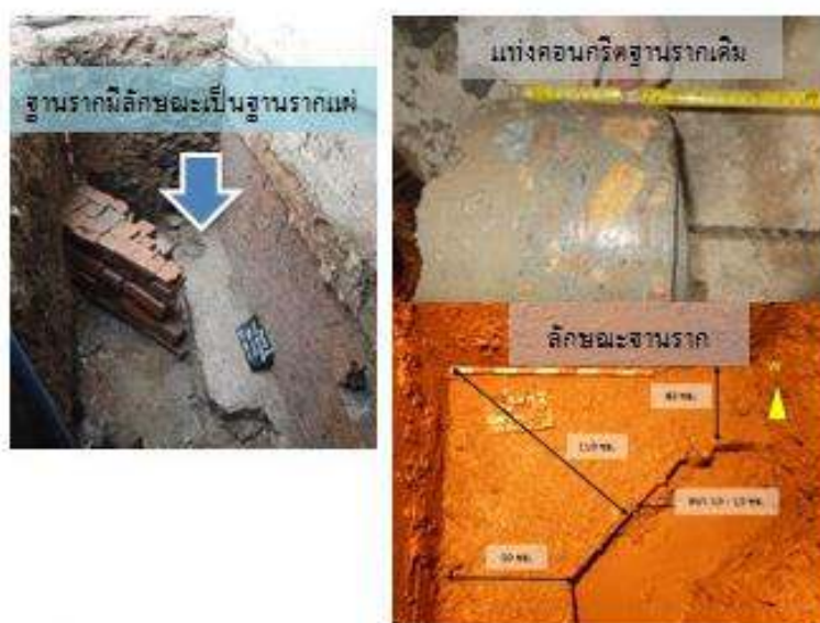
รูปที่ 2.13 ฐานรากแผ่ของอาคารรองรับตลอดแนวผนัง
