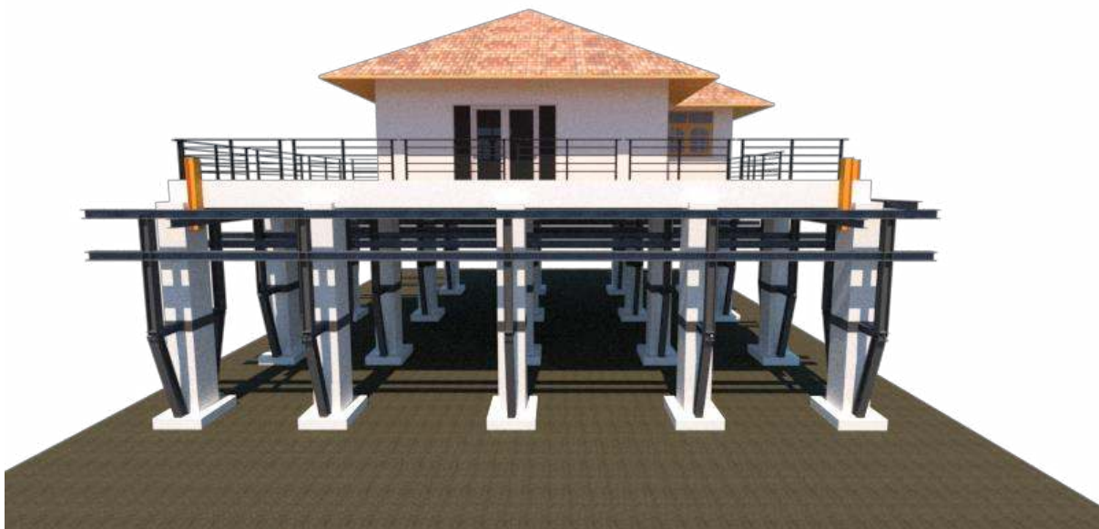
รูป 4.29 แบบจำลองเรือนเล็กกลางหลังติดตั้งโครงสร้างรับแรงจากอาคารด้านบน
