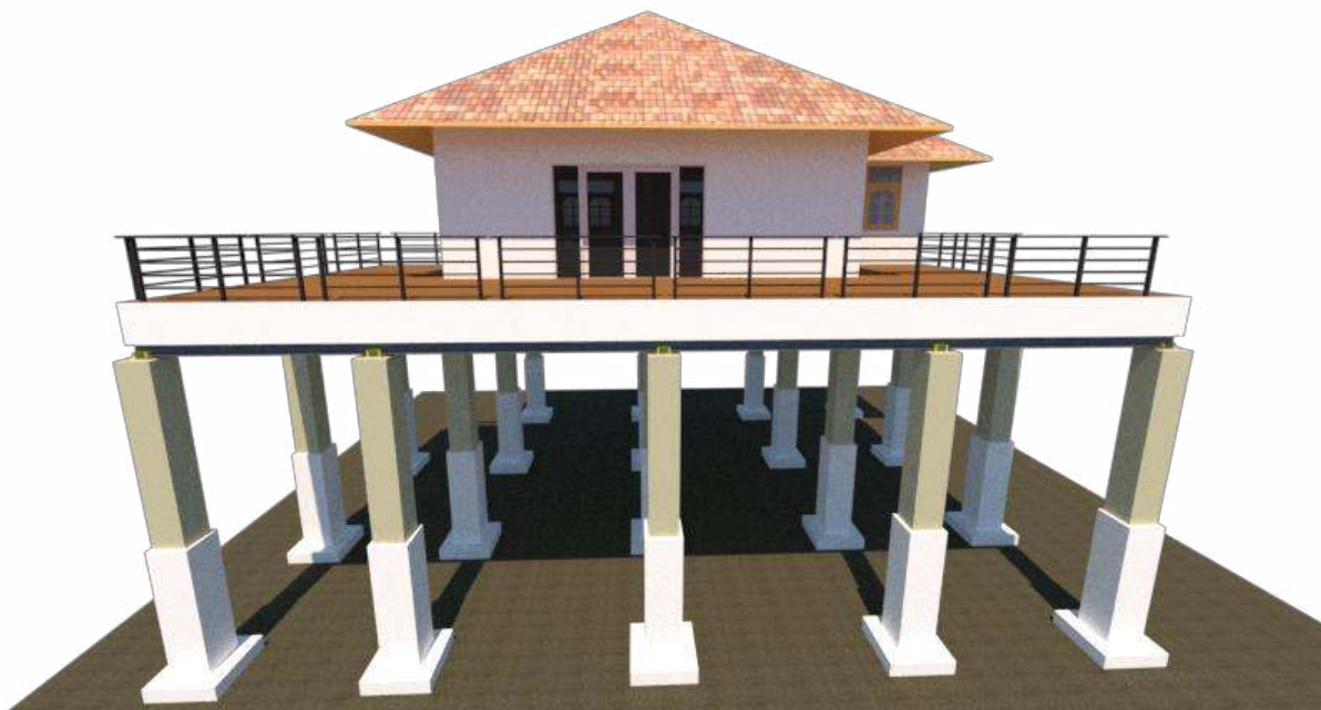
รูป4.41 เรือนเล็กกริม หลังจากเปลี่ยนเสา และ ยกอาคาร
