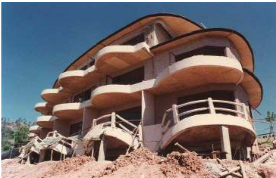
รูปที่ 2.34 อาคารได้ทรุดตัวต่างระดับ
