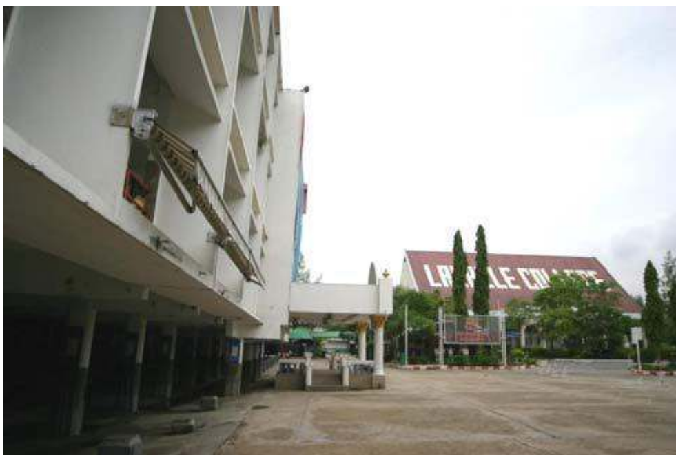
รูปที่ 2.26 อาคารเรียนยวงเดอลาซานเกิดการทรุดตัวเอียงมาด้านหน้า
