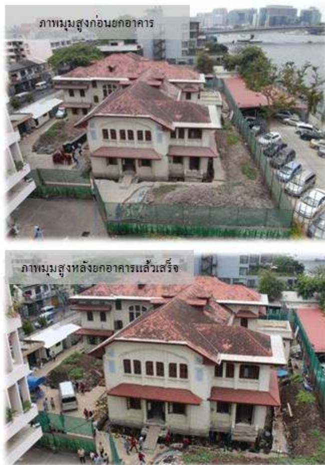
รูปที่ 2.25 แสดงอาคารก่อนและหลังทำการยก
