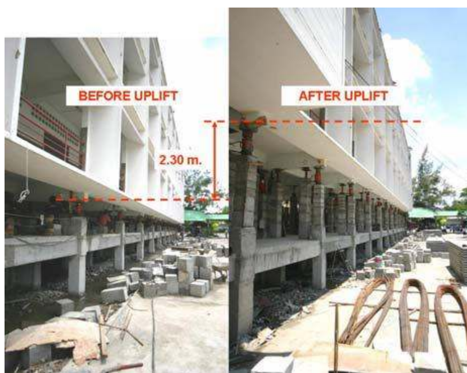
รูปที่ 2.33การยกปรับระดับอาคารทั้งหมด 230 เซนติเมตร
