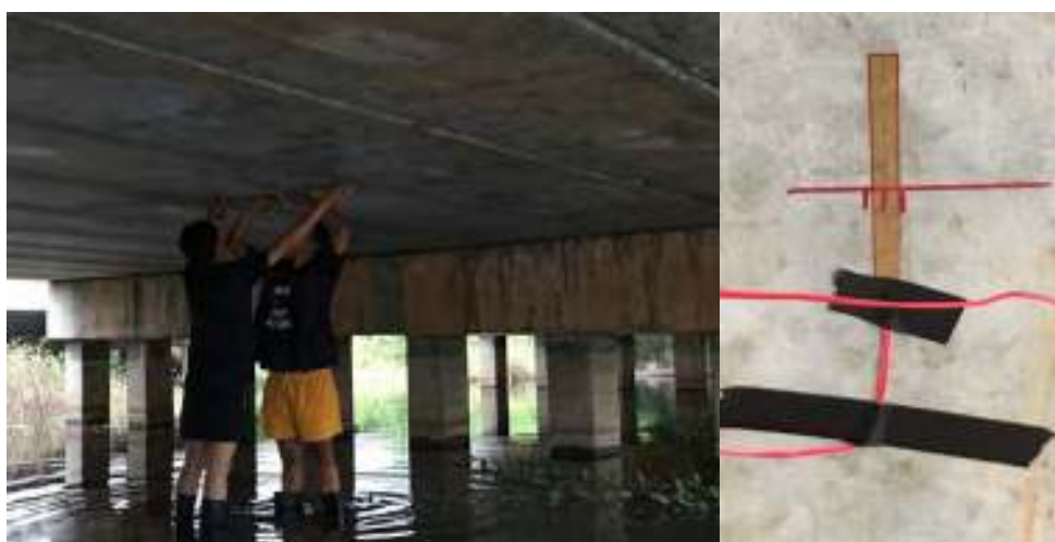
ภาพที่ 3-13 การติดตั้งมาตรวัดความเครียด
