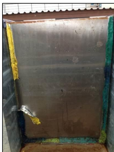
ภาพที่ 3-11 การอุดรูรั่วด้วยดินน้ำมัน
