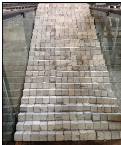
ภาพที่ 3-15 พื้นลูกบาศก์คอนกรีตจัดเรียงแบบบันได
