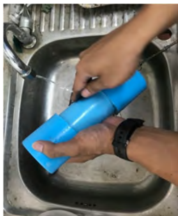
รูปที่ 4.22 ทำความสะอาดท่อ PVC
