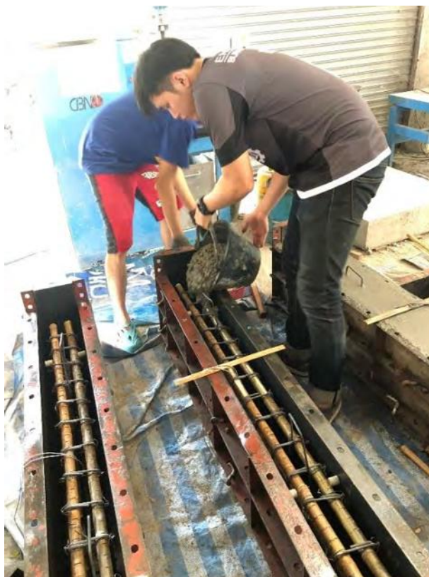
รูปที่ 3.19 การเทคอนกรีตใส่แบบหล่อ
